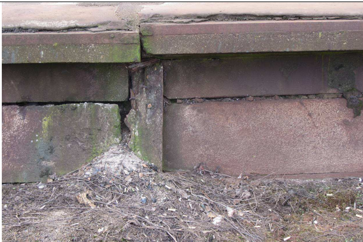
Zdj. nr 3. Zniszczony słupek, zapadnięta deska żelbetowa i krawężł peronowa
