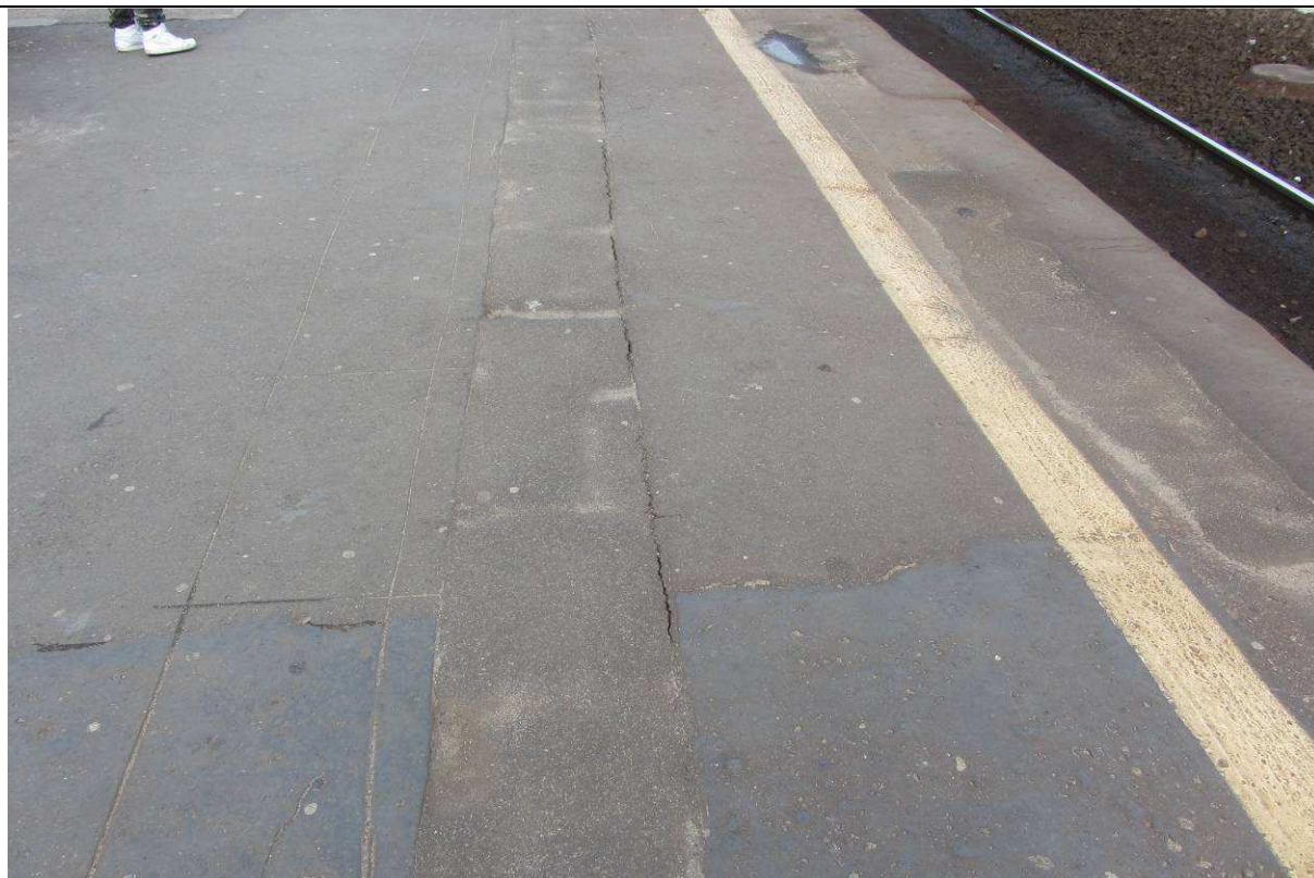
Zdj. nr 13. Podłużna rysa w nawierzchni peronu.
