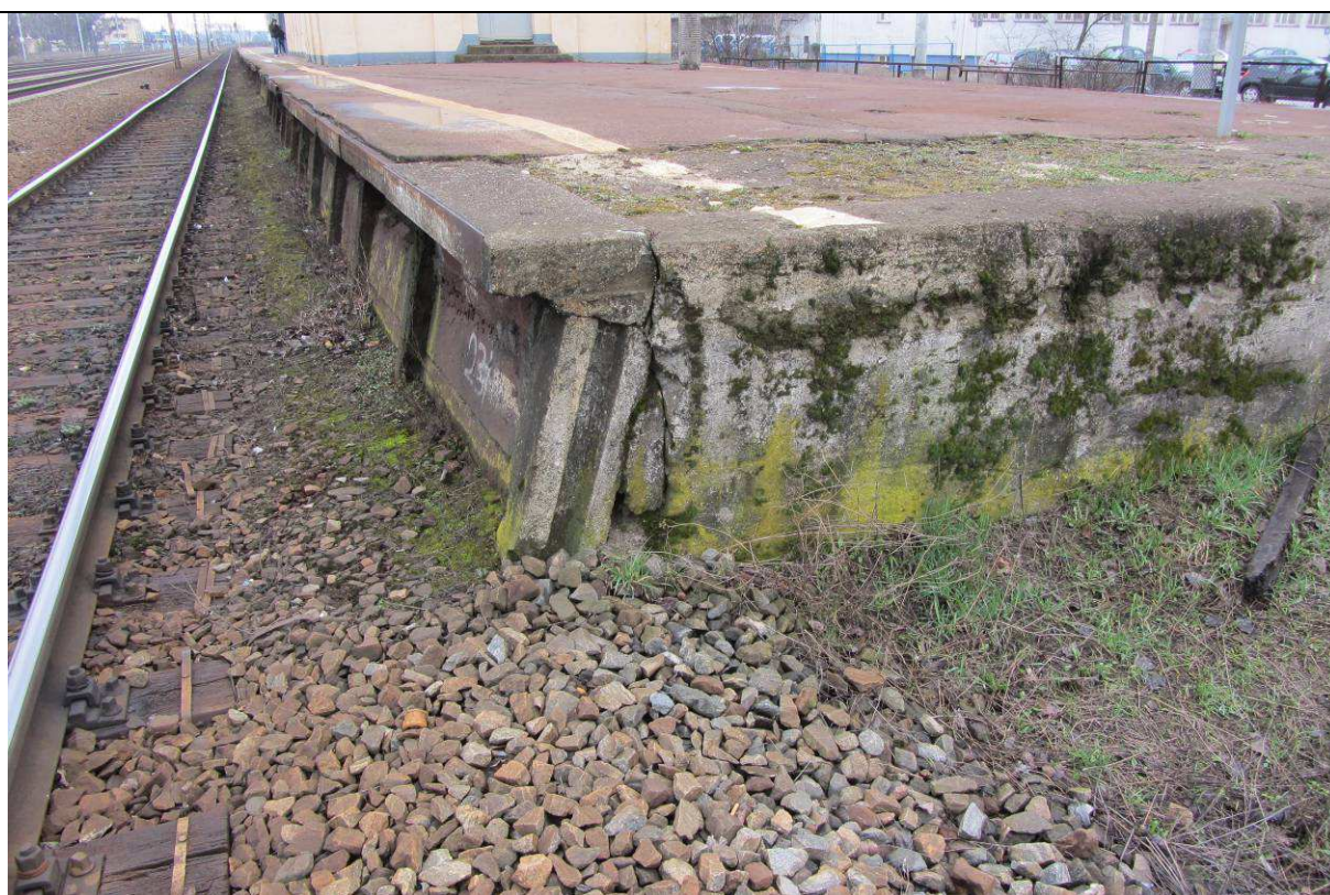
Zdj. nr 6. Czoło peronu od strony toru nr 501 i Gdyni Chylonii. Widoczny kształt słupków ścianki peronowej
