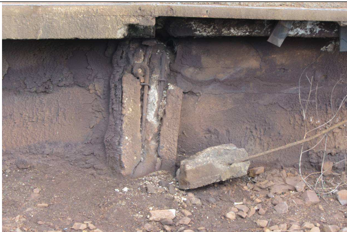
Zdj. nr 11. Jeden z wielu zniszczonych słupków od strony toru nr 502.
