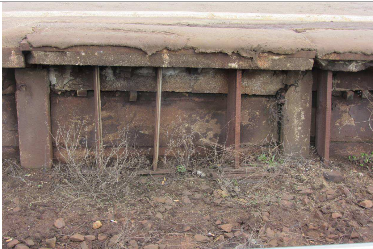
Zdj. nr 9. Przemieszczona krawędź peronu, podparta prowizorycznie deskami drewnianymi.
