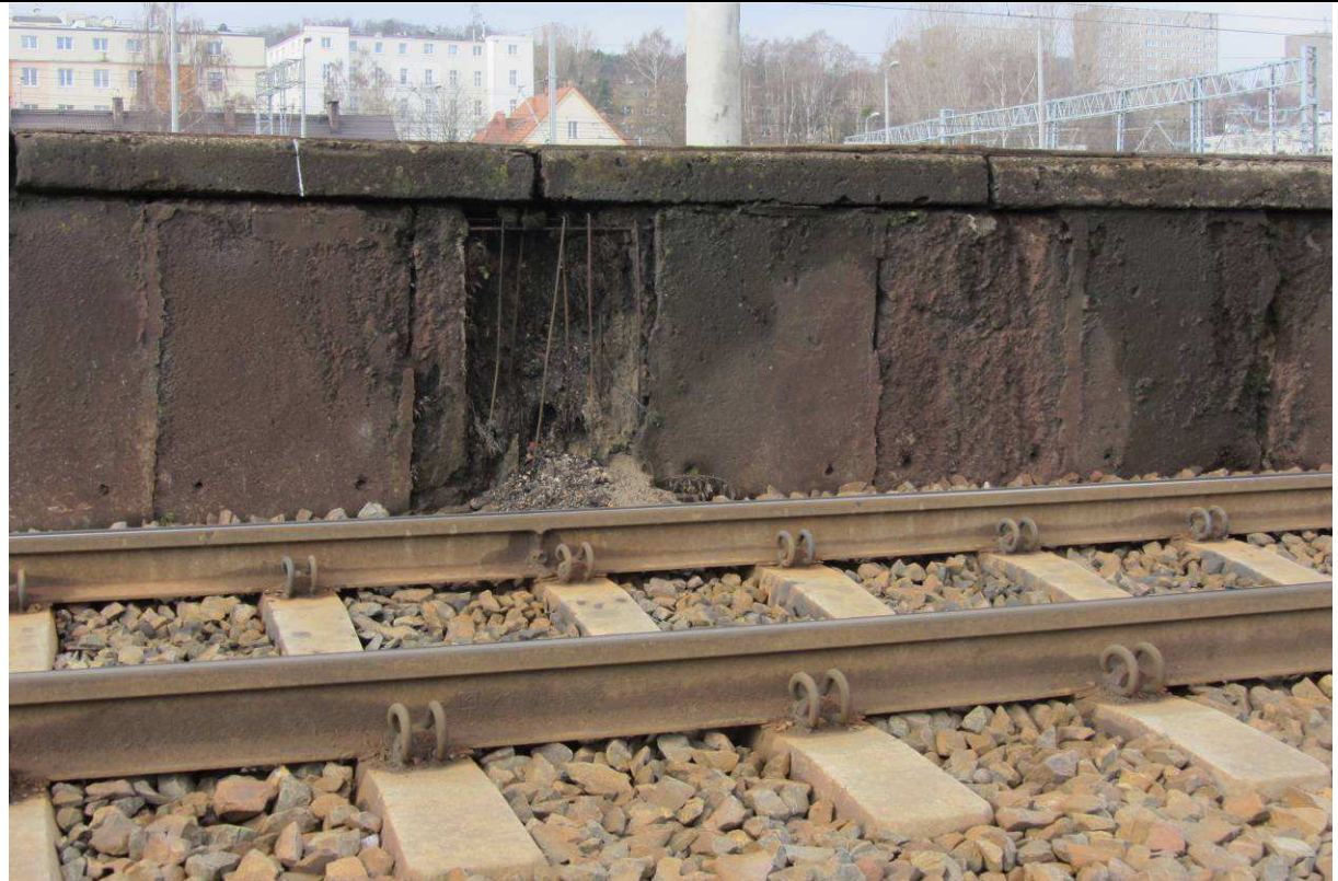
Zdj. nr 3. Zniszczona ścianka peronowa
