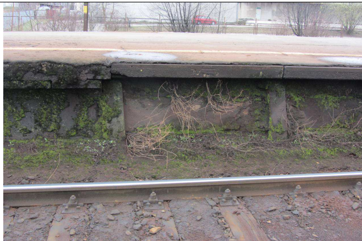
Zdj. nr 2. Zmiana typu ścianki peronowej z wklęsłej na słupki i wypełnienie deskami żelbetowymi.
