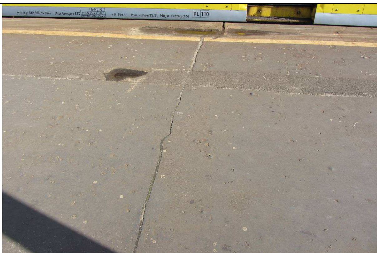
Zdj. nr 14. Poprzeczna rysa w nawierzchni peronu.
