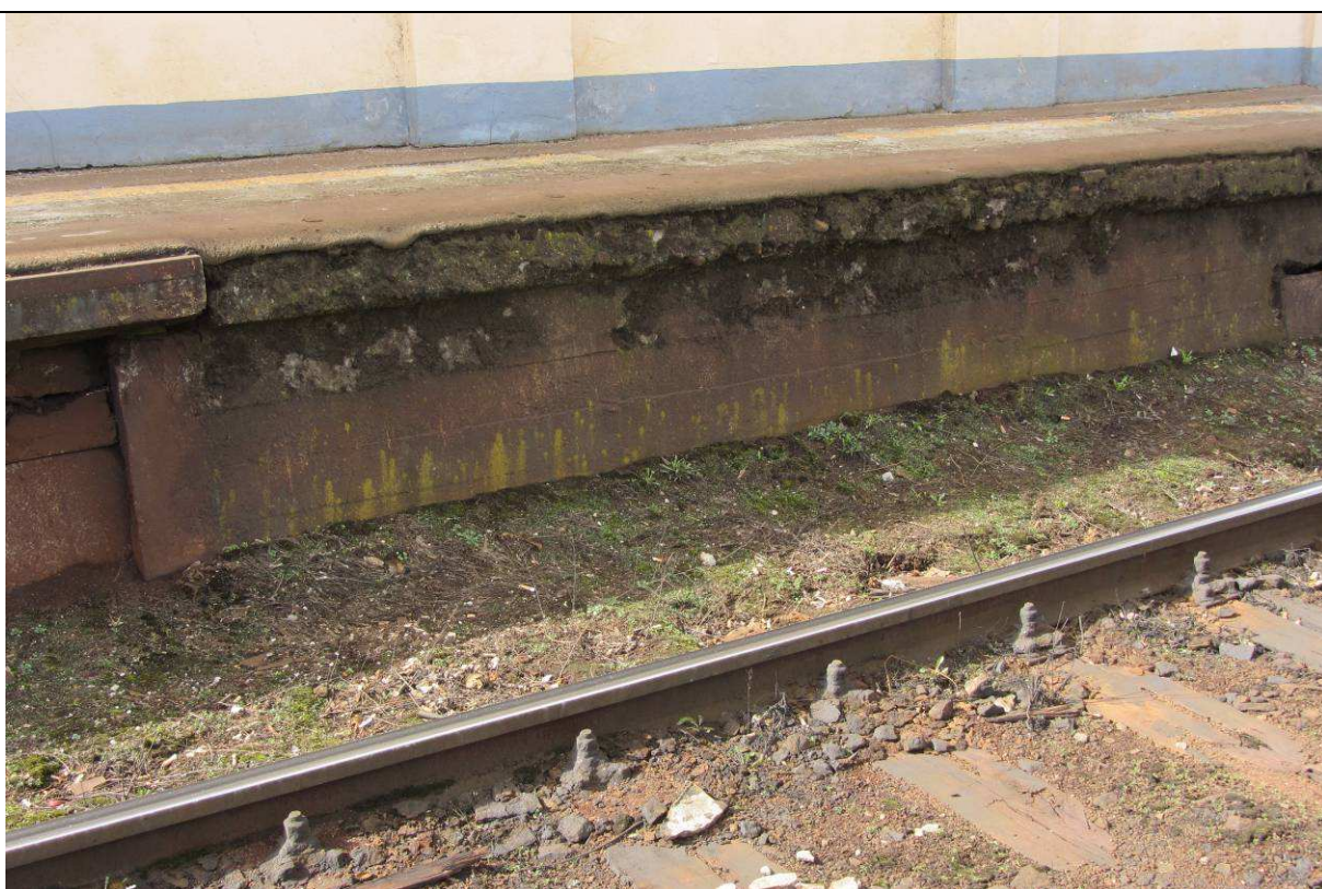
Zdj. nr 4. Krawężł peronu nad przejściem pod torami, widok od strony toru nr 501. Stan dostateczny.
