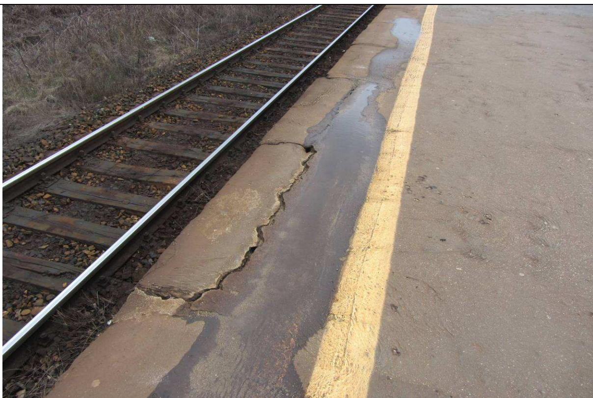
Zdj. nr 10. Widok z góry na przemieszczoną krawędź peronu.
