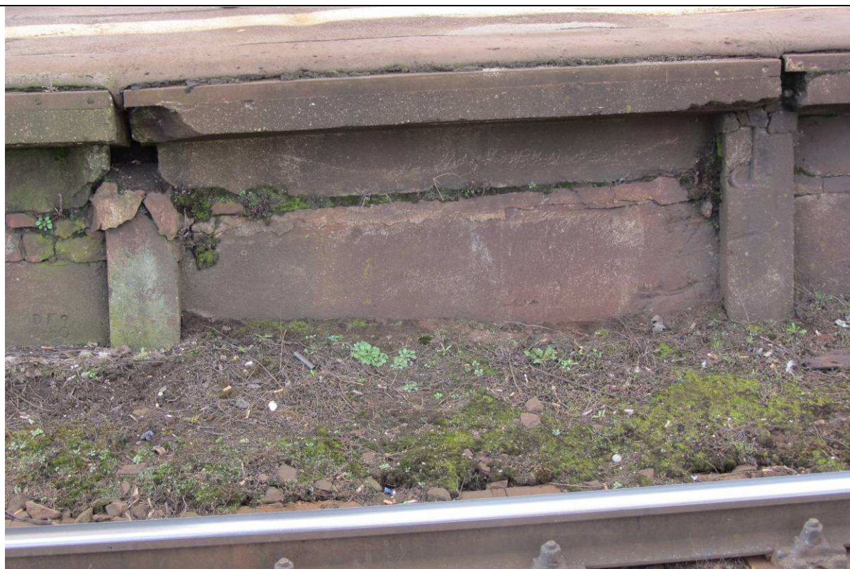
Zdj. nr 5. Zniszczone słupki i uszkodzone deski żelbetowe od strony toru nr 501.
