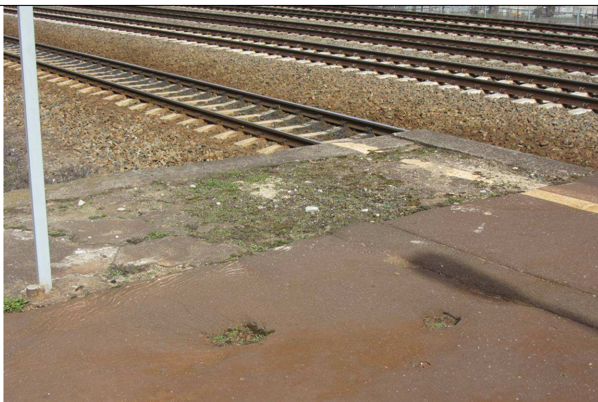
Zdj. nr 12. Brak nawierzchni asfaltowej na końcu peronu od strony Gdyni Chyloni. Zagłębienia w nawierzchni.
